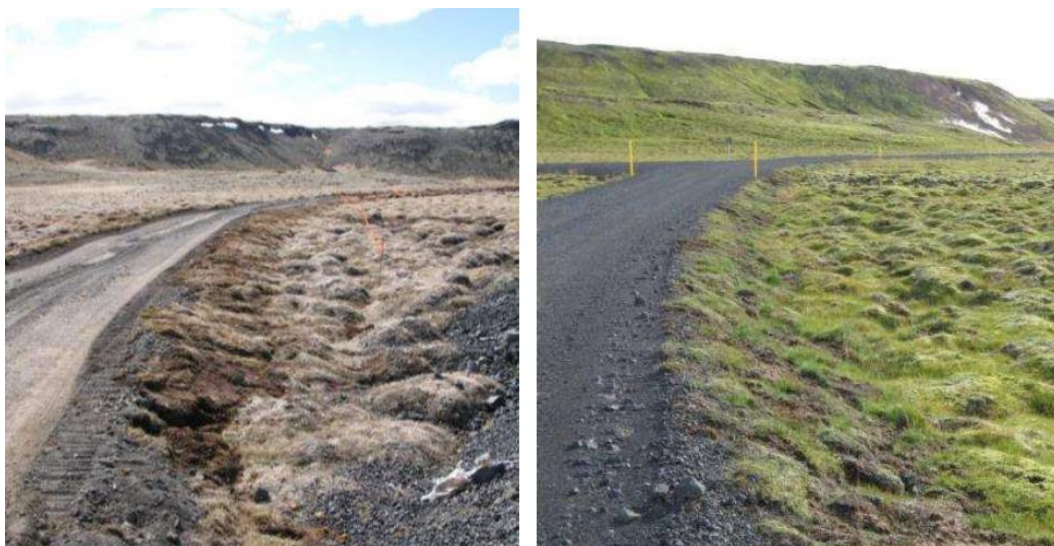
Mynd 4.4 Dæmi um endurheimt staðargróðurs við slóða út að Hverahlíð. Myndir teknar 2007 og 2008
